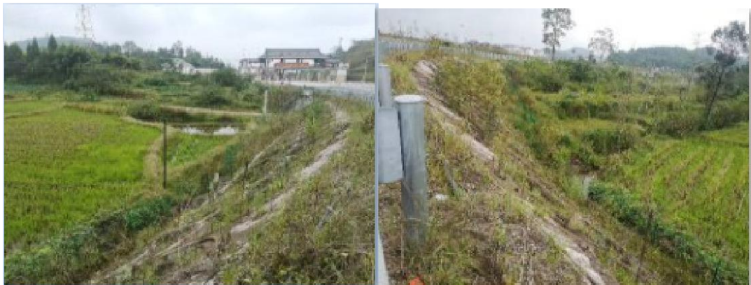
图 5.4.2 边坡防护工程
